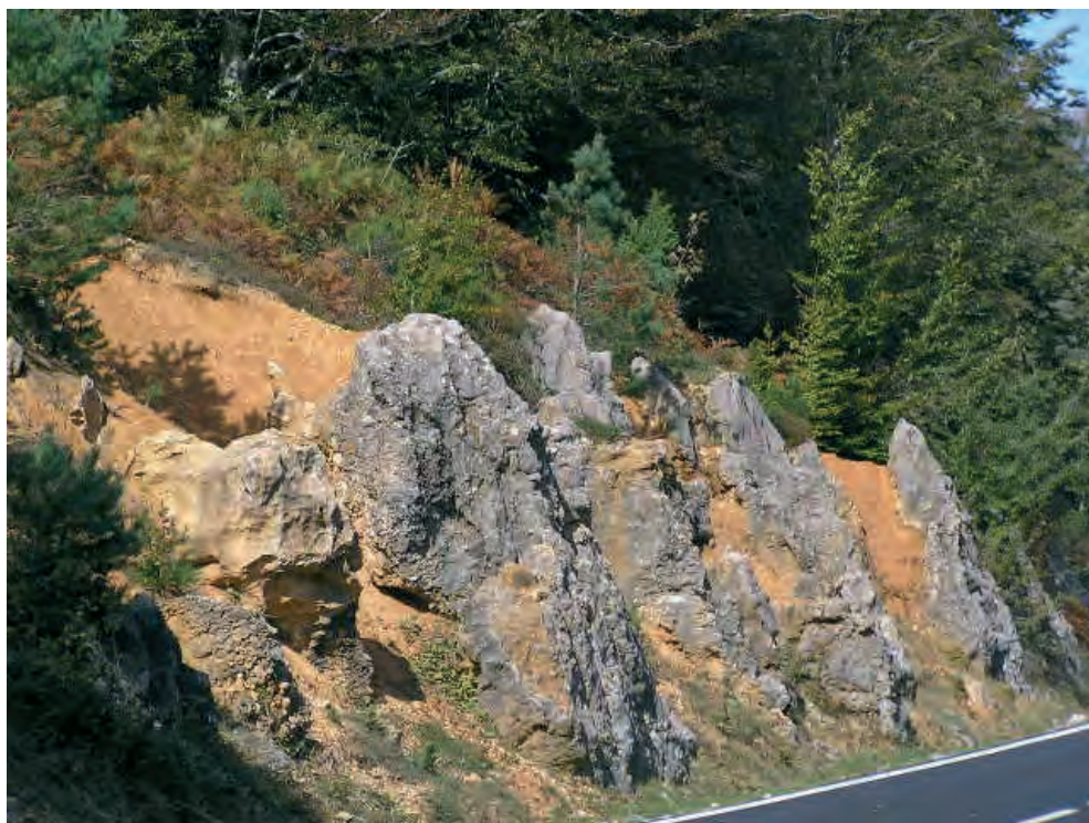
Fig. 59. Detalle de suelos fisurales en la zona de Entzia.
