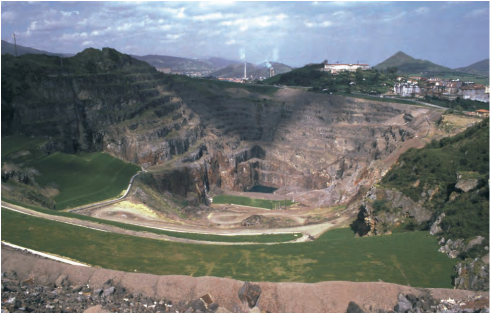
Fig. 79. Hueco de la mina de Gallarta.
