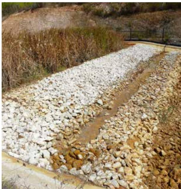
*Estación de biorremediación a base de hacer circular las aguas fuertemente ácidas por un lecho de grava caliza y un filtro vegetal a base de Typha sp.*
