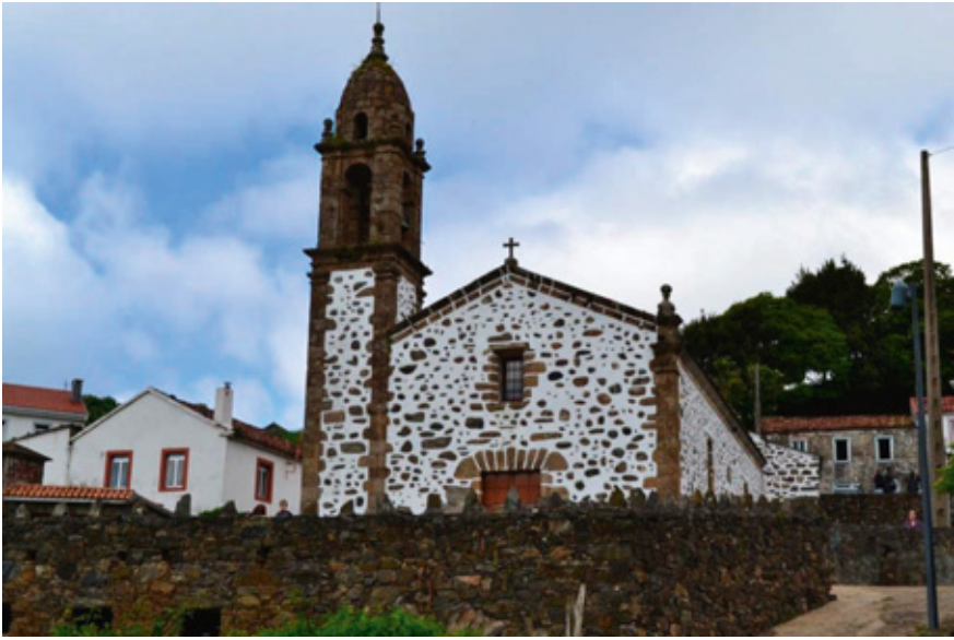
Fig. 13.- Los muros de la iglesia y casas de de San Andrés de Teixido contienen un muestrario de la gran variedad de rocas granulíticas más o menos migmatizadas.
