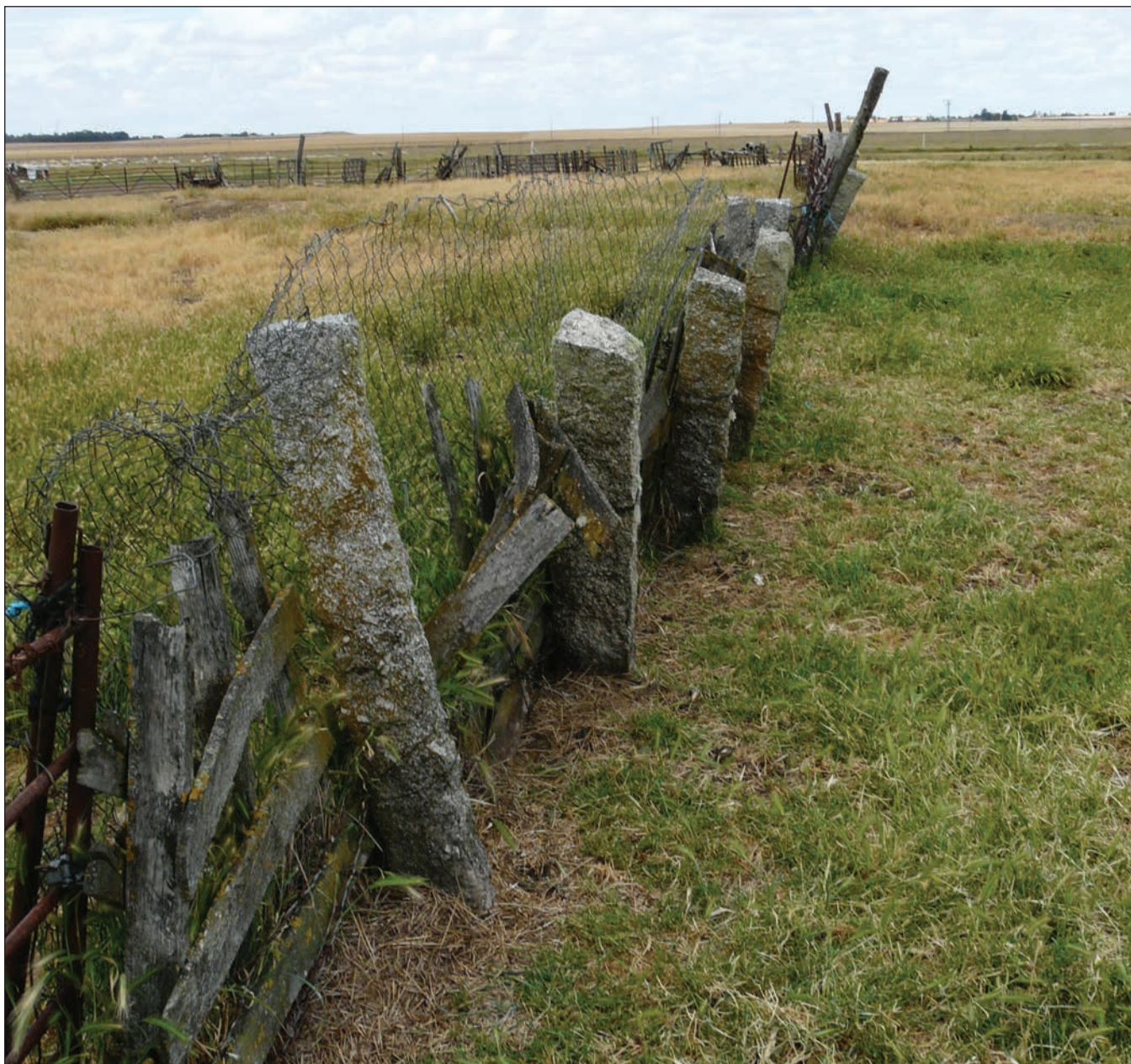
Los postes "bailan" en un suelo con arcillas expansibles: es necesario conocer los suelos al asignar usos al territorio
