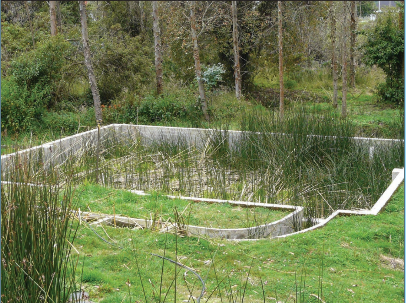
Estación de depuración primaria de aguas usadas domésticas por medio de un filtro verde de totora y juncos en un humedal artificial
